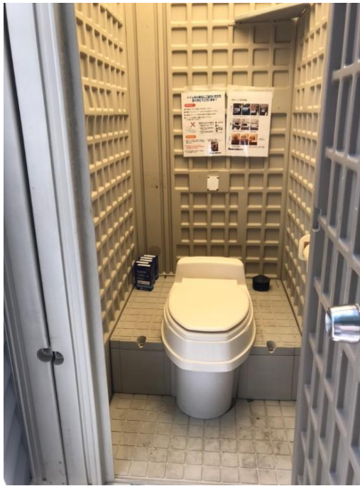
政府調達で設置した 洋式化した和式トイレ （愛媛県宇和島市）
